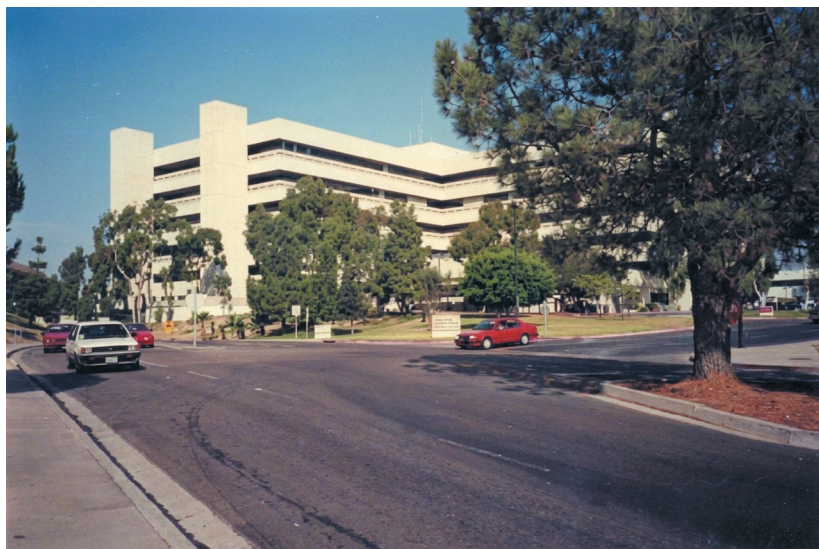
Корпус университетского госпиталя
